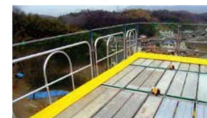
工事現場での足場の仮設構造物に取り付け、メッシュシートだけでは防ぎきれない、工具や資材などの、落下や飛び出しを防ぎます。プラスチック製なので非常に軽く、簡単に持ち運びができます。固定用の穴があり、お手持ちの金具等で固定でき作業効率もアップ!! 加工性が高く、現場に合った仕様に加工することも可能です。
