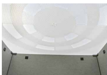
天井には採光性のある素材を使用。
