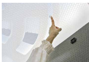
天井の換気口は、調整可能。
